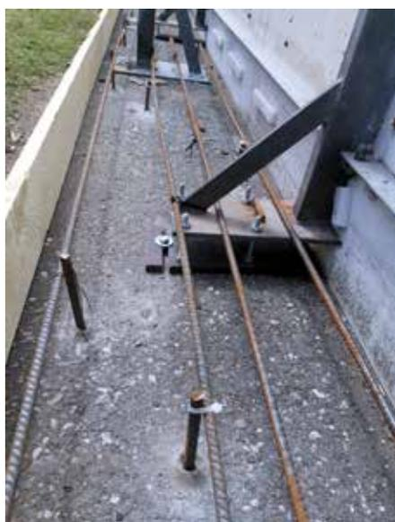
**Foto:** Mehr als 180 Laufmeter des Bandensockels wurden armiert und eingeschalt
