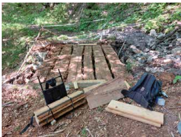
Fotos: Die Brückenbauteile einschließlich Geländer wurden mit „Kraxe“ zur Baustelle getragen und dort eingebaut.
