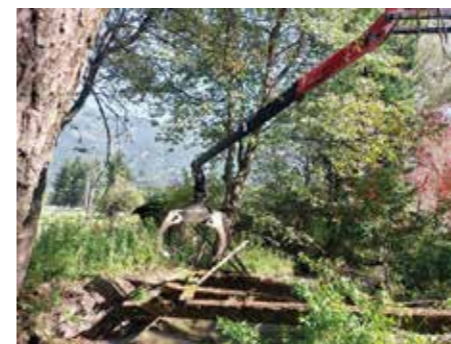
Foto: Abriss des alten Bauwerks
