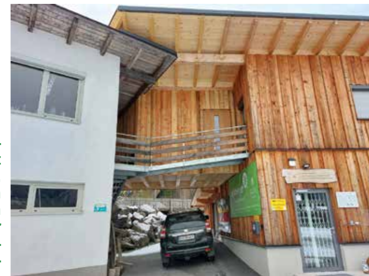
Foto: Zwischen Mehrzweckhaus und Centrum Carnicum eingebaut
