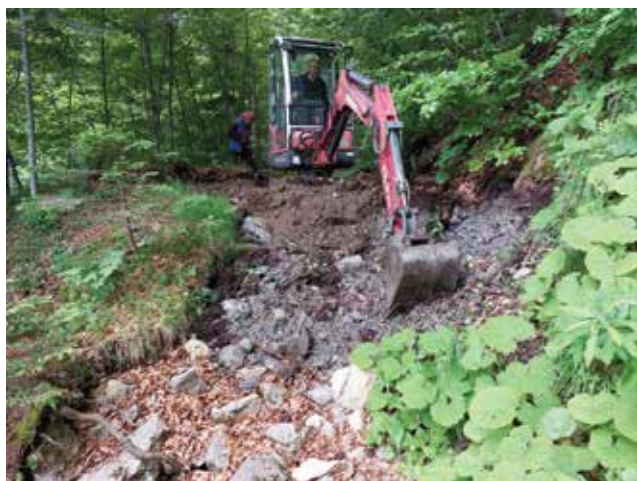
Fotos: Massive Erosionen konnten durch Steinschichtungen und Auffüllung mit Schotter beseitigt werden.
