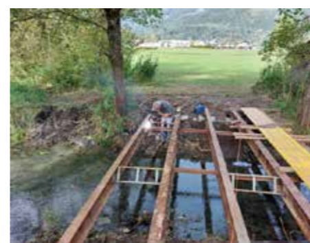
Foto: Schweißarbeit am Tragwerk
