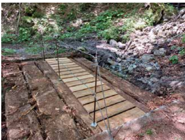
Fotos: Die Brückenbauteile einschließlich Geländer wurden mit „Kraxe“ zur Baustelle getragen und dort eingebaut.
