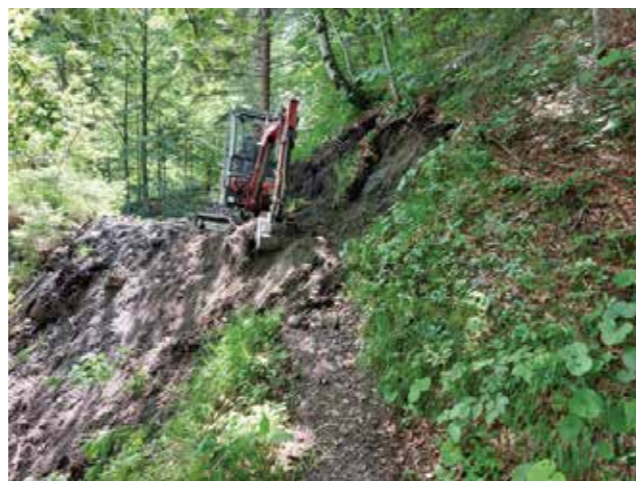
Fotos: Massive Erosionen konnten durch Steinschichtungen und Auffüllung mit Schotter beseitigt werden.
