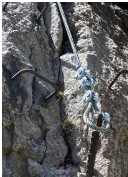
Foto: Neue Seilanschlüsse
