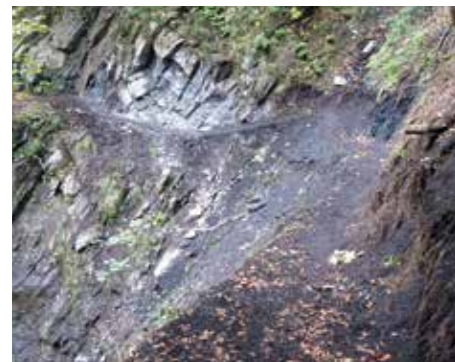
Foto: Weg ist neu heraus gesprengt
