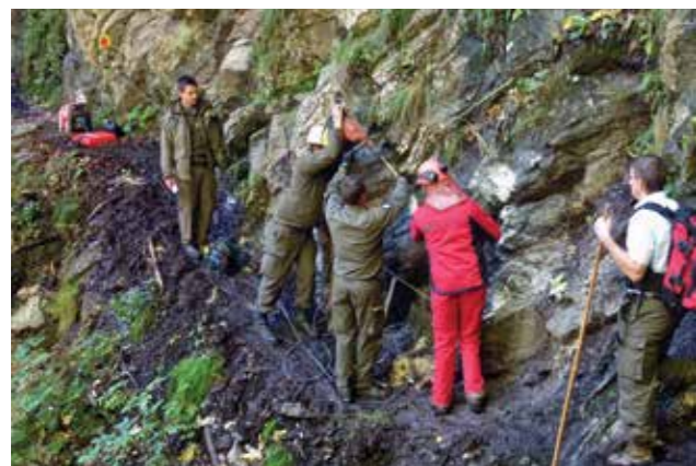
Foto: Pioniere bei Bohrarbeiten für Felssprengung
